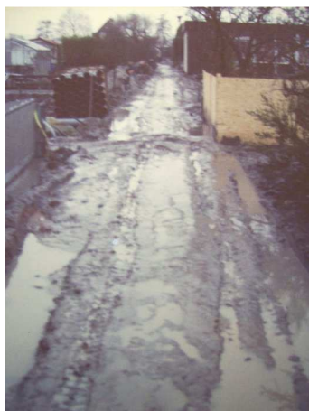
Het hoofdpad, een en al modder met opslag van buizen, waterleidingrollen e.d.
